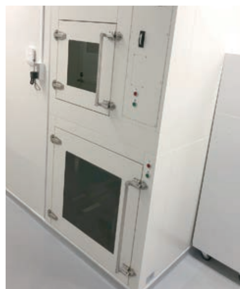
「パスボックス」新設(写真②)
